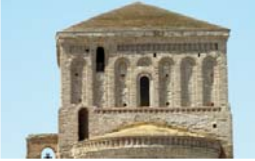
Arévalo. La Lugareja. Cornisa del ábside y cimborrio
