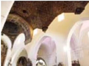
San Nicolás de Madrigal. Arcos formeros y arranque de la armadura de la nave, arco toral y ochavo
