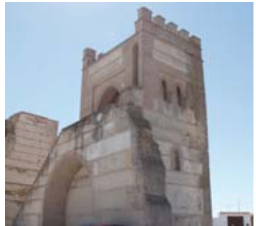
Madrigal. Torre del castillo de San Hilario restaurada con el arco túbido inferior inventado
