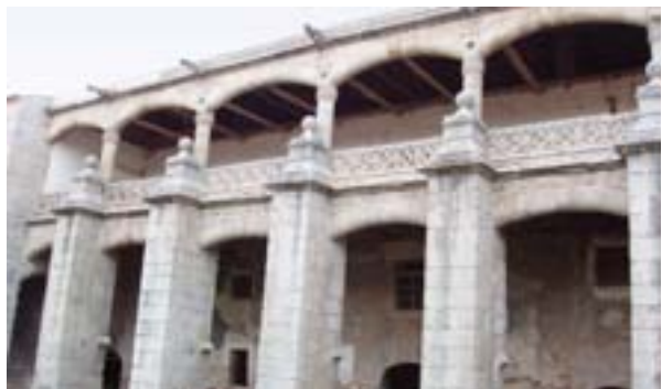
Castillo de Castronuevo en Rivilla de Barajas. Galería gótica reforzada
