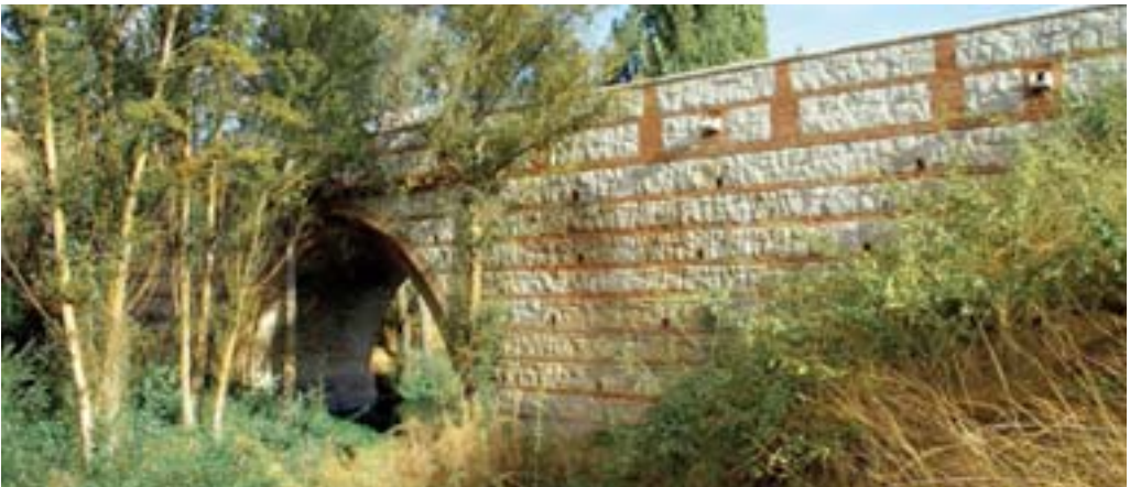
Puente de los Barros de Arévalo
