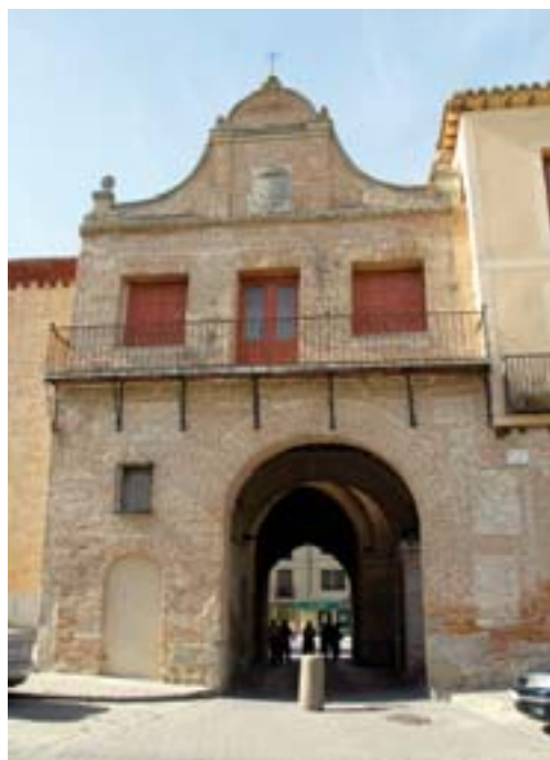
Interior de la Puerta de Alcocer de Arévalo
