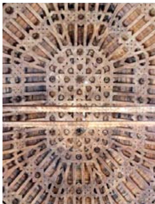
Armadura de la cabecera
