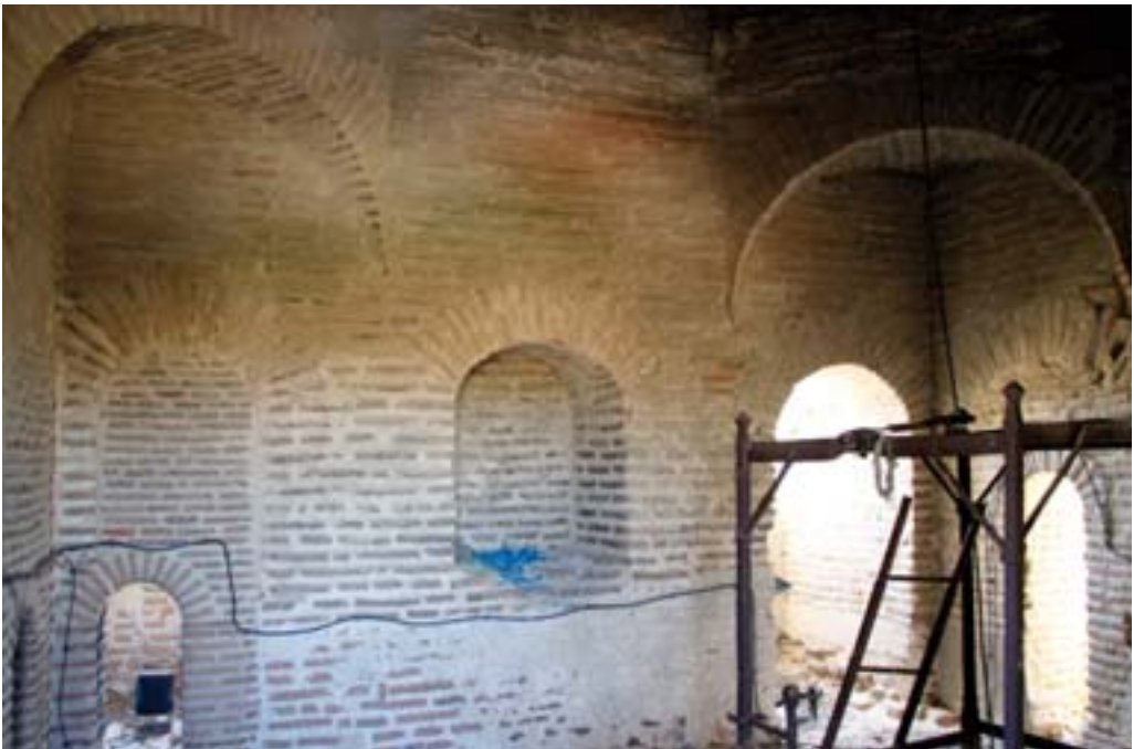
Hornacina y trompas bajo la bóveda
