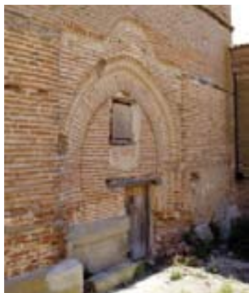
Nuevo acceso a la torre tras ser forrada
