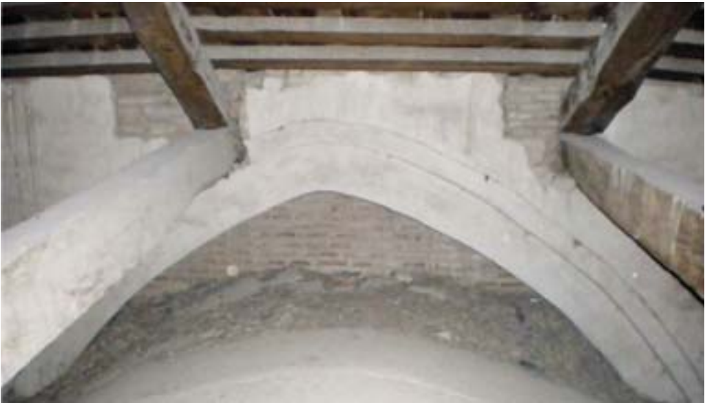
Bajocubierta, formero original. Foto I. Hernández García de la Barrera
