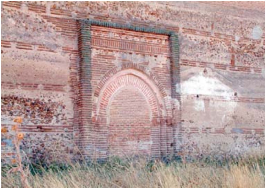
Blasconuño de Matababras. Puerta cegada con arco túmido o de herradura apuntado
