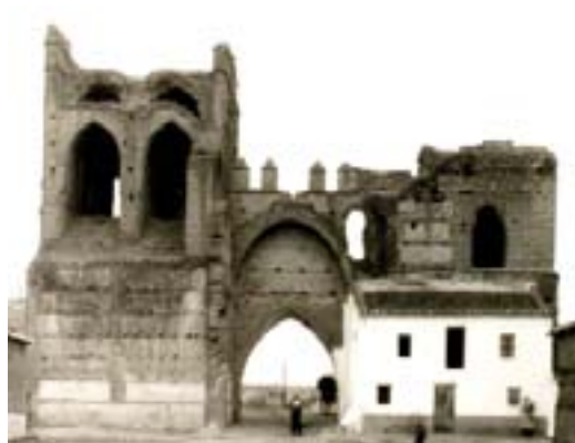
Madrigal. Puerta de cantalapiedra h. 1926. Archivo MAS- Diputación de Ávila
