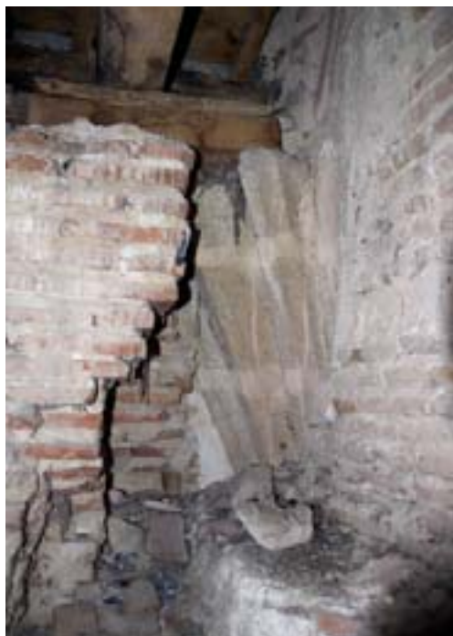
Arranques de los nervios para las bóvedas de la nave central
