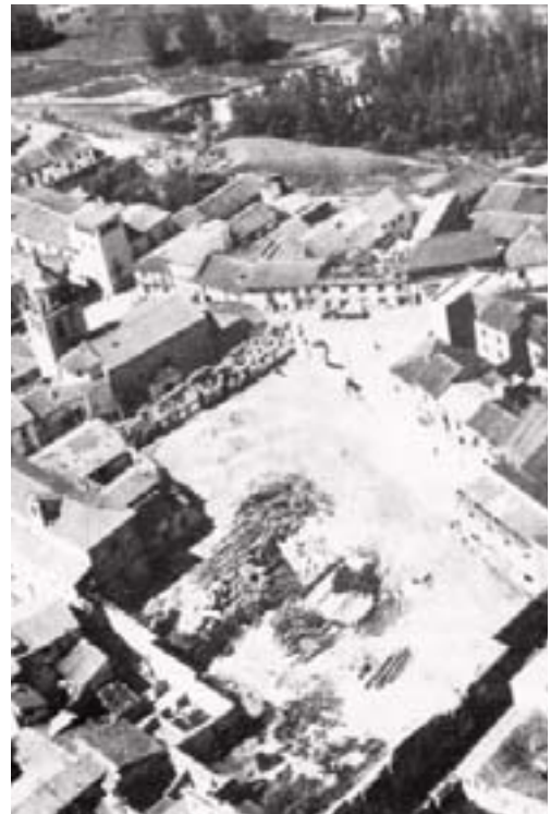
Demolición del palacio en 1976. Foto Sanz
