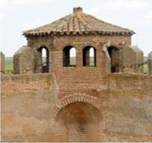
Castillo de Narros de Saldueña. Trompas de las garitas angulares
