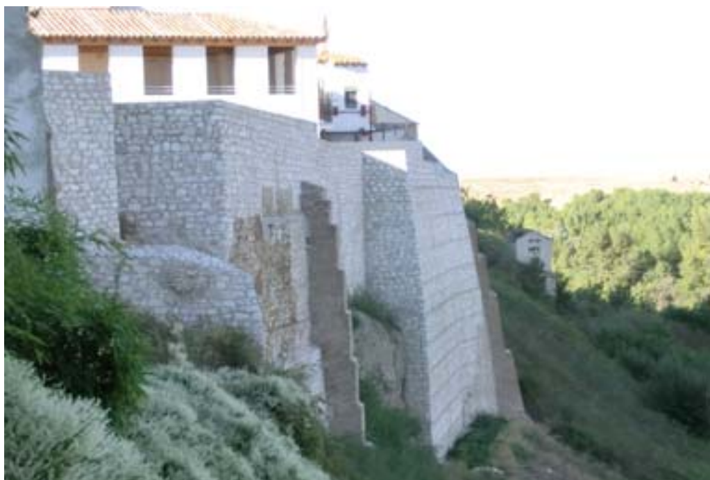
Restauración en la zona del mirador del Adaja. Francisco Jurado 2011
