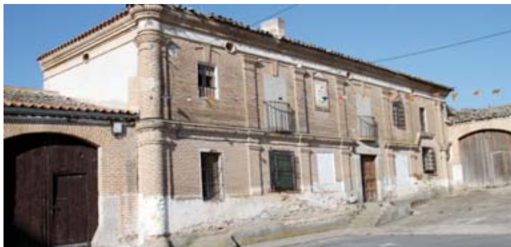
Cabezas del pozo. Casona nobiliaria
