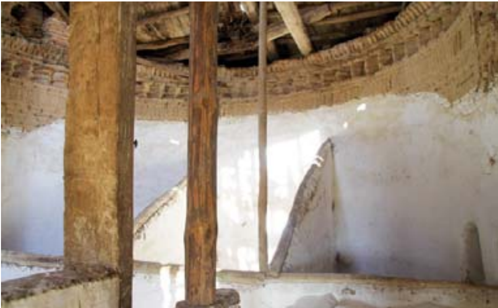
Interior del ábside central
