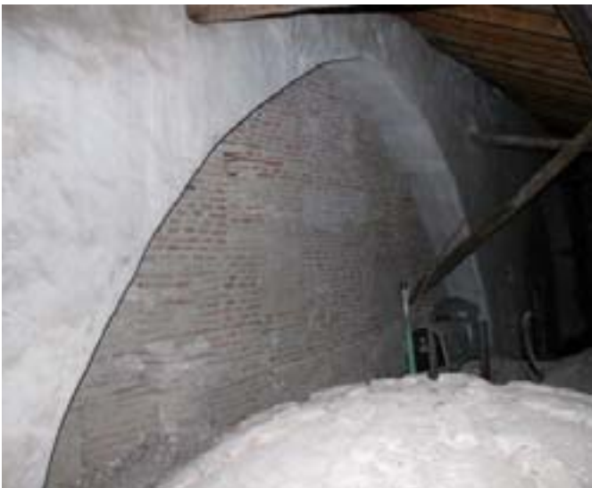
Bajocubierto, formero norte
