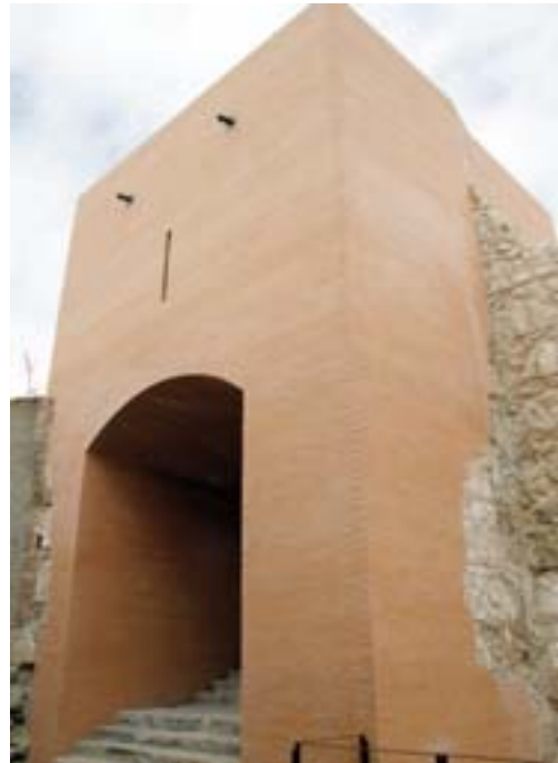
Nuevo torreón puerta con cámara superior. Muralla de Arévalo
