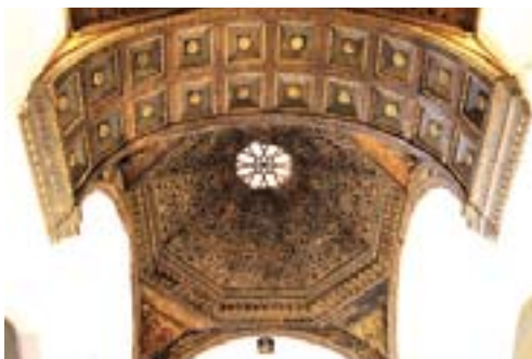
San Nicolás de Madrigal. Arco toral y armadura ochavada del presbiterio
