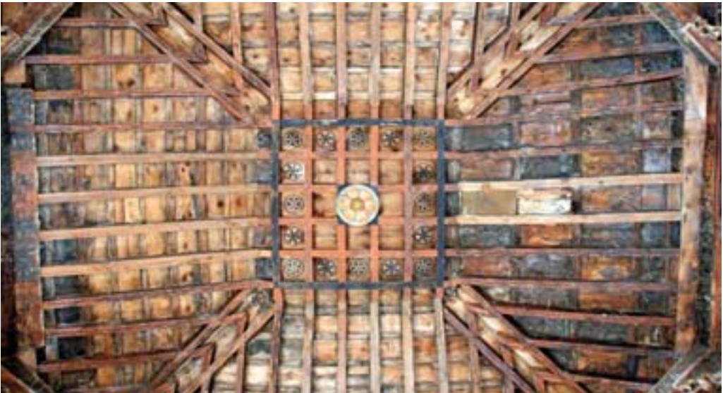
Armadura de la cabecera
