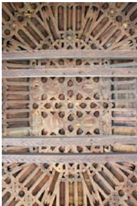
Armadura de la nave
