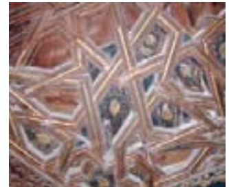
San Nicolás de Madrigal, paño policromado de la armadura de la nave central
