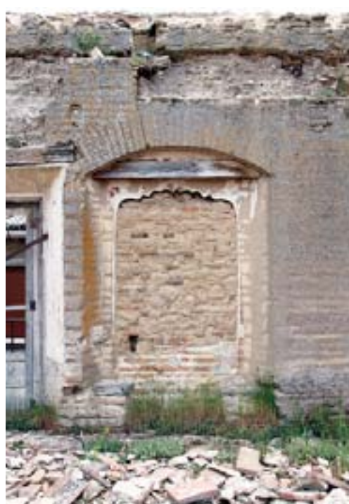
Arévalo. Palacio de los Sedeño. Ventana central desde el interior
