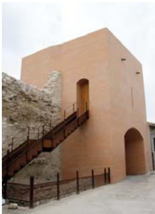
Interior del nuevo torreón puerta con cámara superior. muralla de Arévalo
