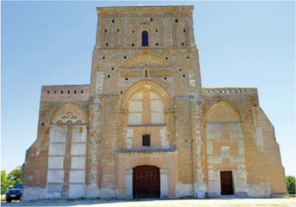
Vista desde el Oeste
