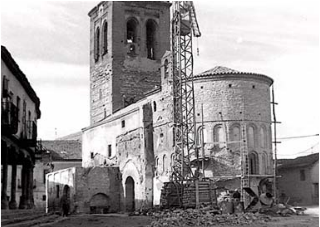
Santa María de Arévalo durante la demolición de las capillas laterales
