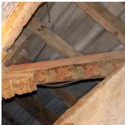
Cuadral de la armadura de la crujía sur del presbiterio del hospital real de Madrigal
