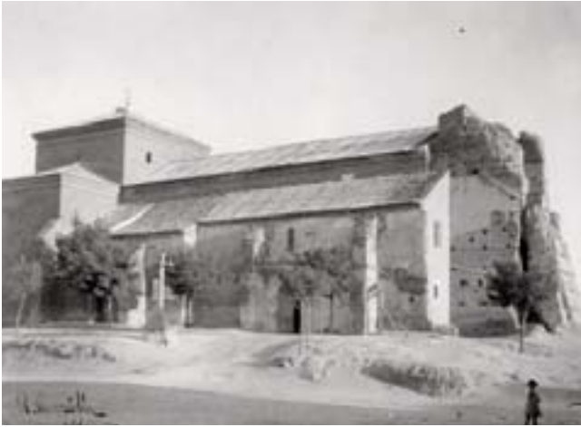
Iglesia con la torre en ruinas. Foto de A. Arenillas (AGA)
