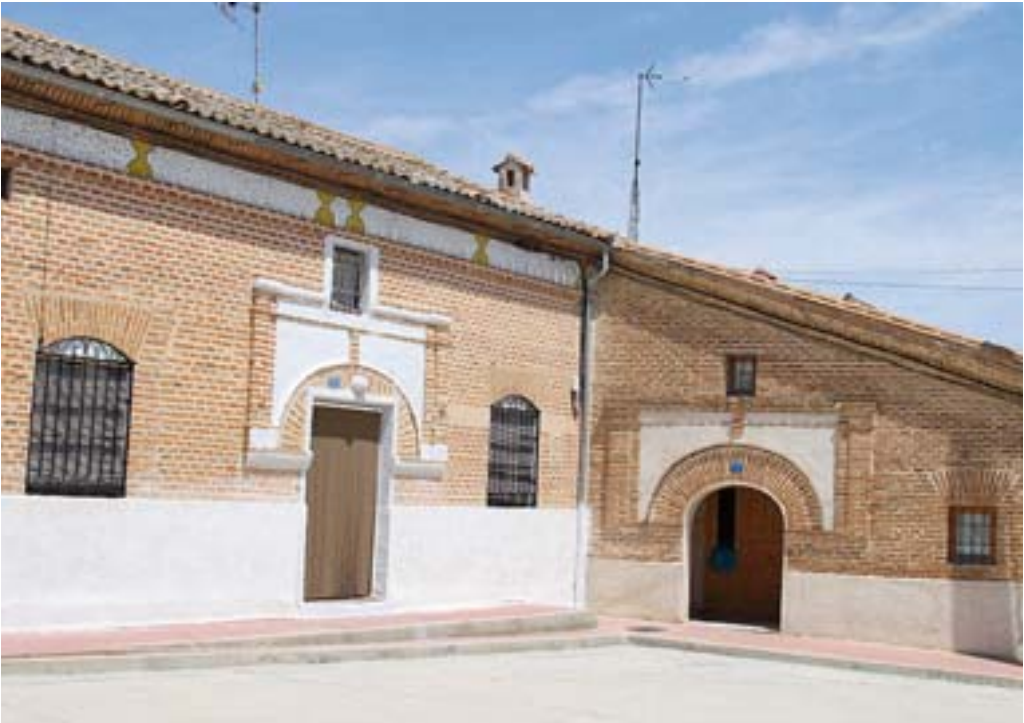
Adanero. Portadas características con rosca de ladrillos convergentes con chambrana, recogidas por alfiz
