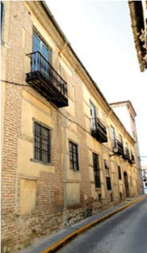
Arévalo. Palacio de Valdelágula. Fachada y torre
