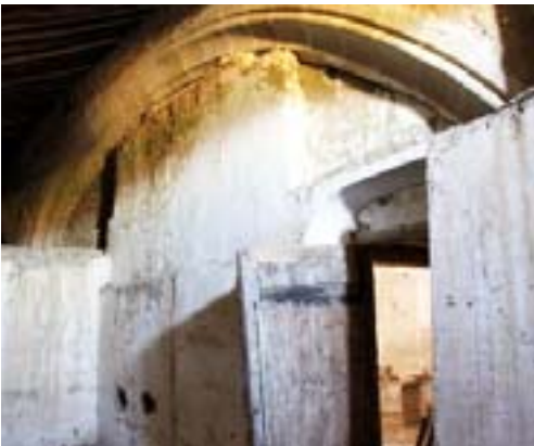
Formero cegado de la nave norte
