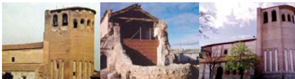
Orbita antes del hundimiento, sin ábside y con el ábside reconstruido
