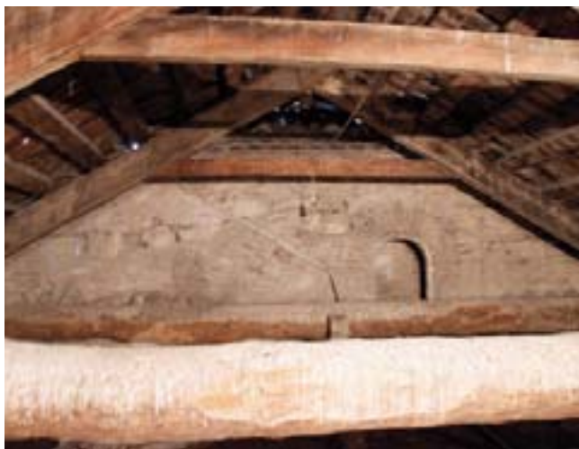
Bajocubierta, vano en el muro occidental del ábside
