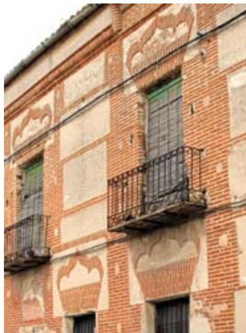
Arévalo. Palacio nuevo de los Montalvo. Detalle
