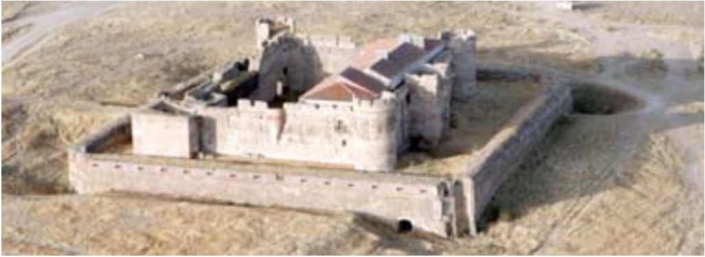
Castillo de Castronuevo en Rivilla de Barajas. Vista aérea de Ricardo Melgar
