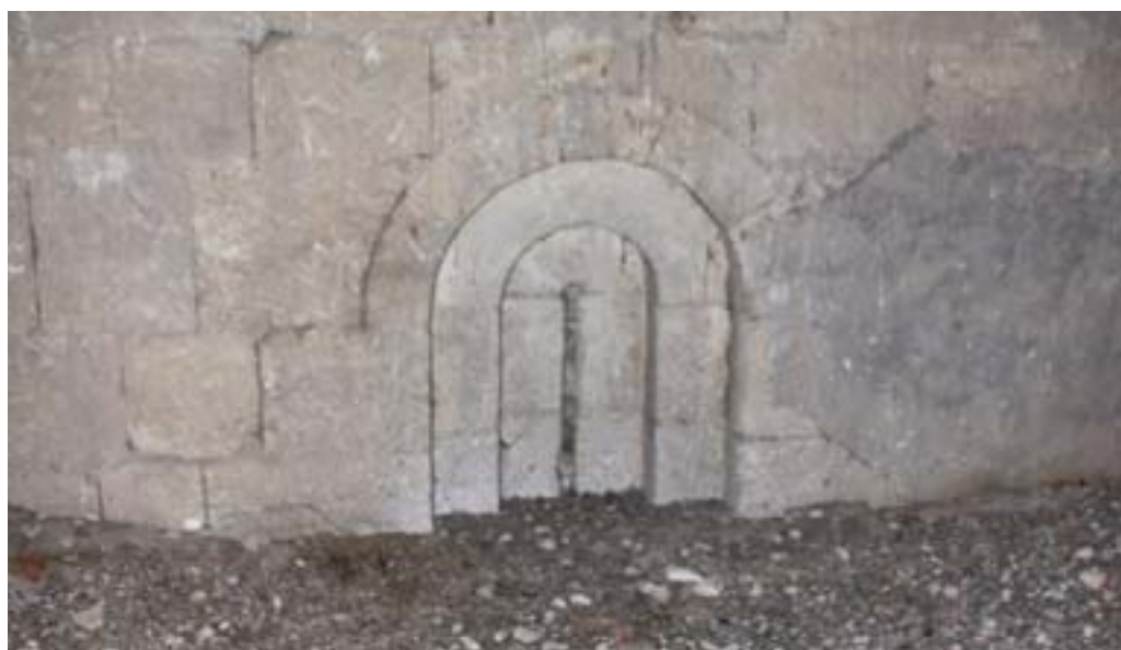
Ventana norte del tramo recto
