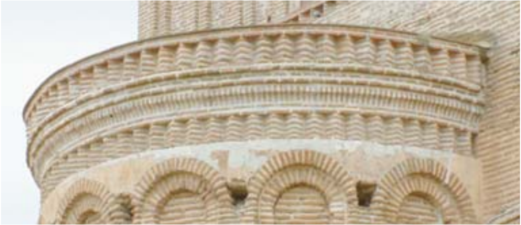
La Lugareja de Arévalo, ábside central con ladrillos en frisos, cornisas y arquerías y revoco de cal en las enjutas
