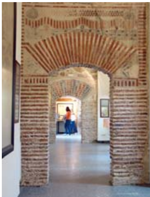
Puertas con yesterías mudéjares de la cruzía norte del claustro de los Reyes de Sto. Tomás de Ávila
