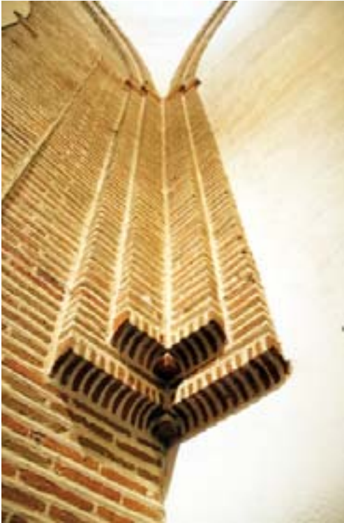
Pilares que no alcanzan el suelo en el ángulo noroccidental de la capilla central
