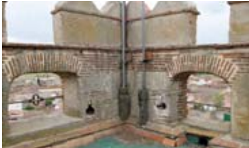
Castillo Narros de Saldueña. Arcos y troneras de la torre
