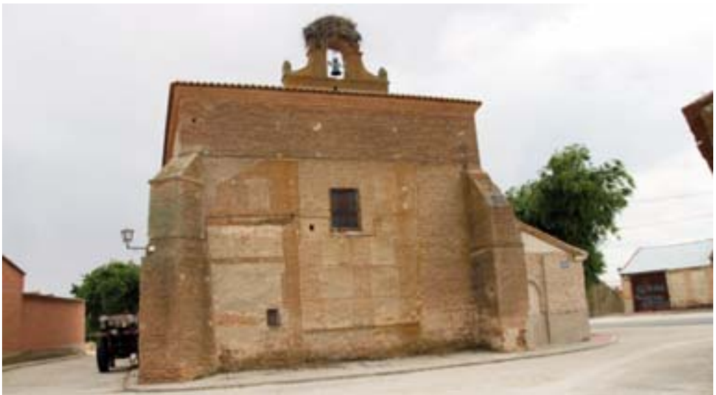
Hastial occidental con las sucesivas reformas
