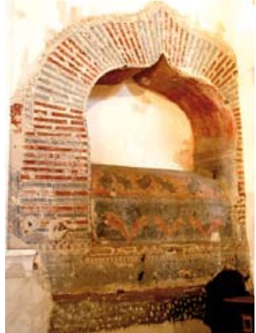
San Miguel de Arévalo. Sepulcro de ladrillo y yeso pintado en el presbiterio
