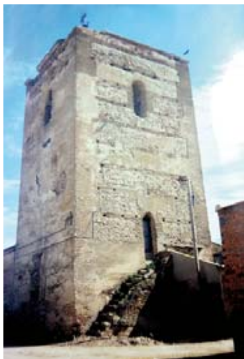
Torre antes de la reforma
