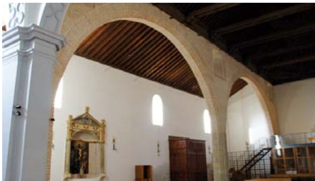
Formeros de la nave meridional
