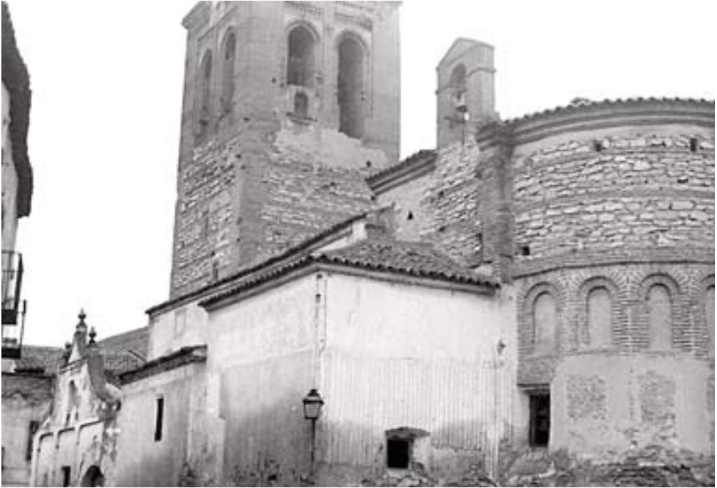
Santa María de Arévalo antes de la demolición de las capillas laterales
