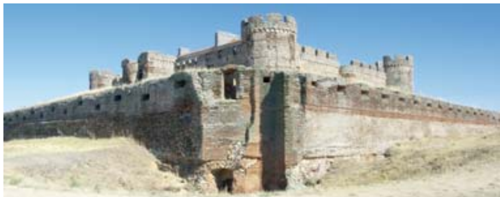
Castillo de Castronuevo en Rivilla de Barajas. Entrada a los sótanos, barrera y fortaleza interior
