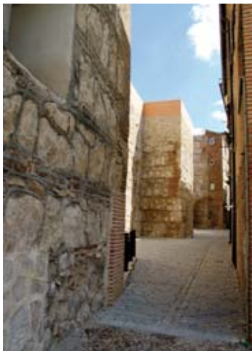
Recercamiento con ladrillos cerámicos de los muros en la calle Casa Blanca
