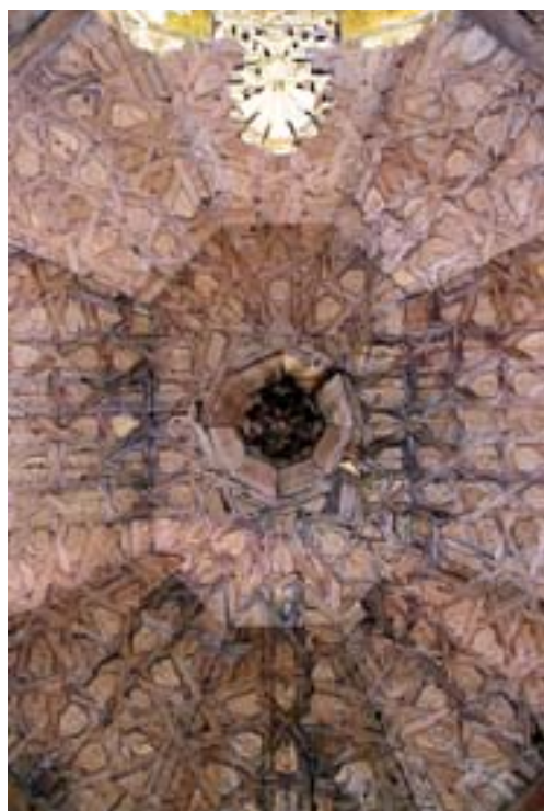
Armadura de la cabecera
